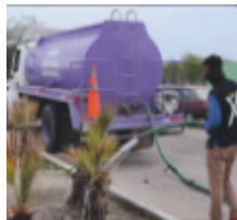
procesos que se realizan en la Planta de Tratamiento, podemos obtener agua de calidad
